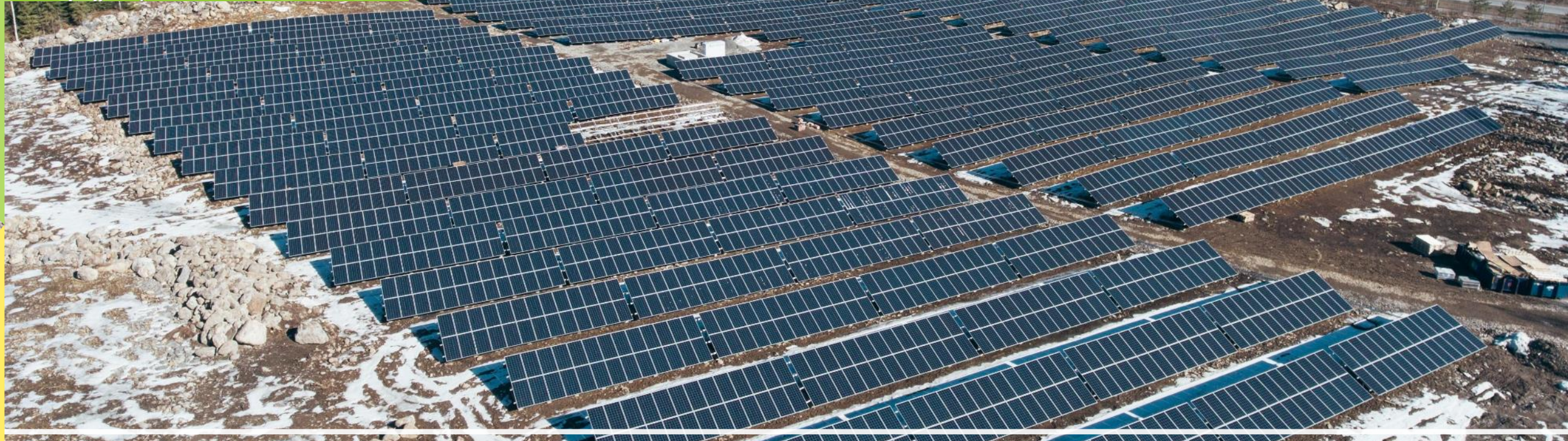
Eteläinen aurinkopaneelientä Teho 2 MW, paneeleita 5 980
