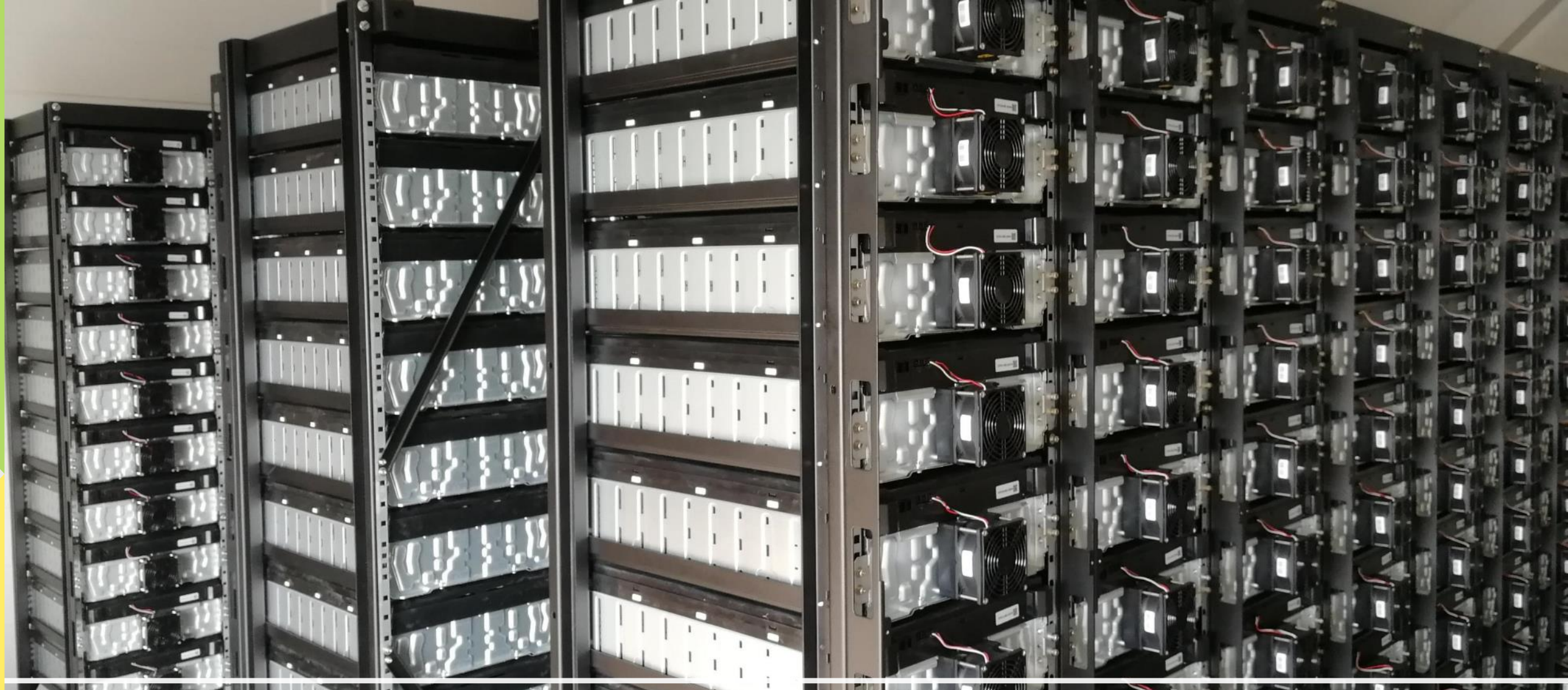
Sähkövarastot eli akut Yhteisteho 4 MW @30 min
